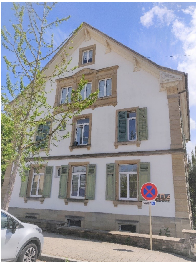
Façade avant – parking personnes handicapée devant l'immeuble Bureau situé au RDC
